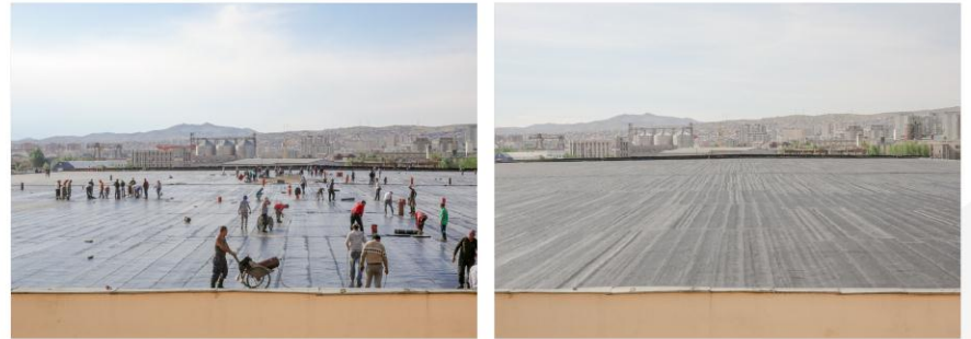
ҮЙЛДВЭРИЙН ДЭЭВРИЙН БАЙДАЛ
